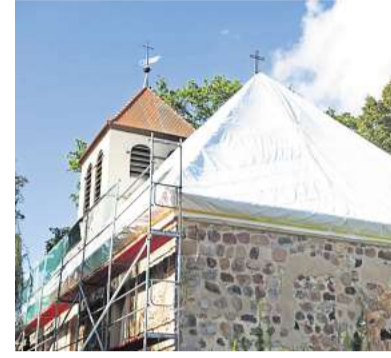
Das Dach des Gotteshauses wurde komplett eingepackt.
