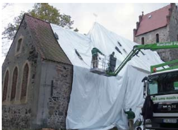
GROLI ist auf die Präzisionsbegasung im Holzschutz spezialisiert und Profi im Begasen von Kirchen und anderen historischen Gebäuden. Dabei ist die maximale Dichtheit um das Gebäude Voraussetzung für umweltfreundliches Vorgehen. Fotos: GROLI
