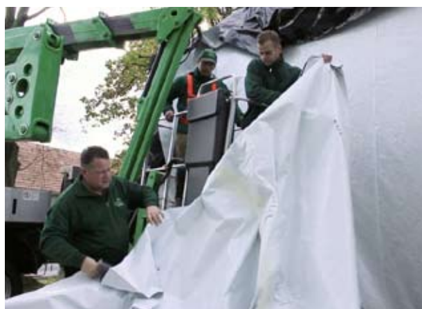
GROLI ist auf die Präzisionsbegasung im Holzschutz spezialisiert und Profi im Begasen von Kirchen und anderen historischen Gebäuden. Dabei ist die maximale Dichtheit um das Gebäude Voraussetzung für umweltfreundliches Vorgehen. Fotos: GROLI
