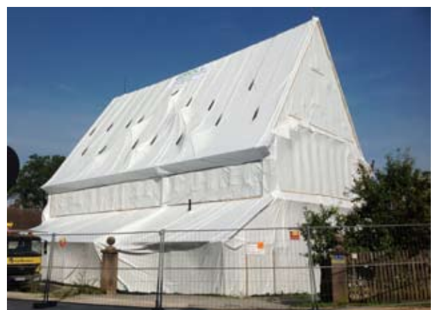
GROLI ist auf die Präzisionsbegasung im Holzschutz spezialisiert und Profi im Begasen von Kirchen und anderen historischen Gebäuden. Dabei ist die maximale Dichtheit um das Gebäude Voraussetzung für umweltfreundliches Vorgehen. Fotos: GROLI
