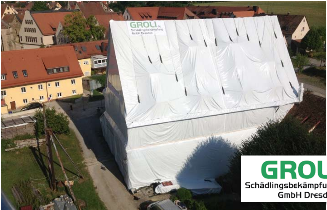
Ein vor der Begasung mit spezieller gasdichter Folie abgedichtetes Fachwerkgebäude gewährleistet eine optimale Eindringtiefe des Bekämpfungsmittels. Foto: GROLI
