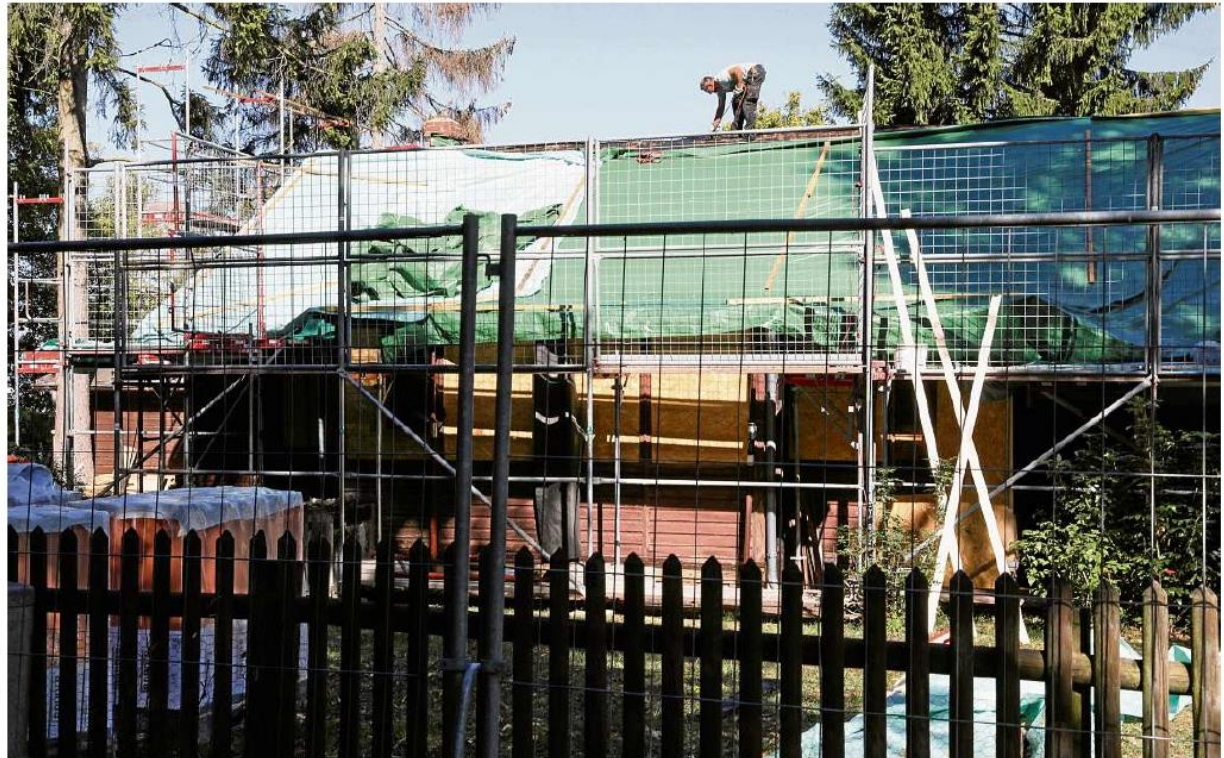
Das Dach der Porschehütte ist abgedeckt, auf dem Dachfirst balanciert ein Arbeiter. Das 80 Jahre alte Gebäude wird in Absprache mit der Denkmalbehörde saniert.
