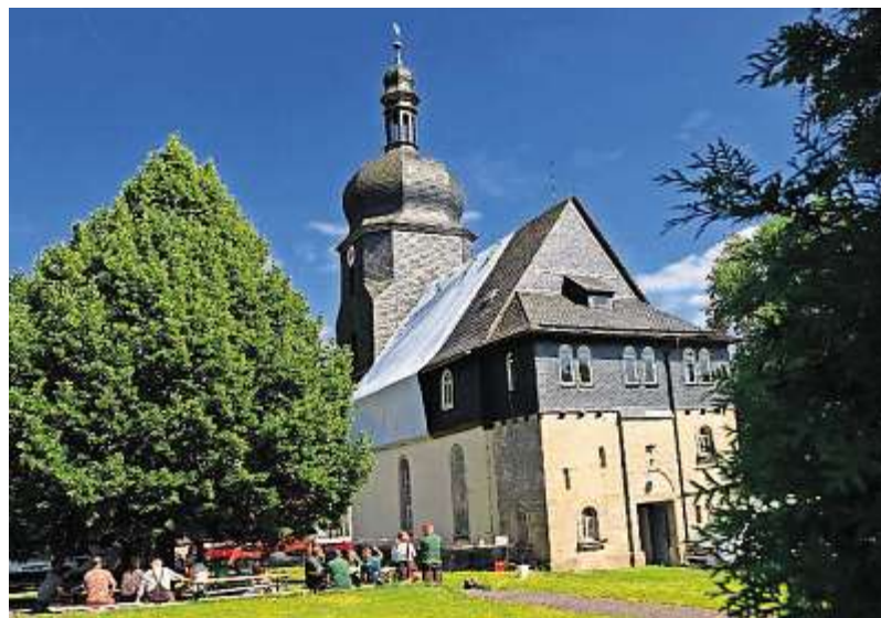
Kirchenschiff und Sakristei werden à la Christo mit Folie eingeschlagen, um dem Holzwurm im Deckengebälk – hinter der Verschieferung – zu Leibe zu rücken.
