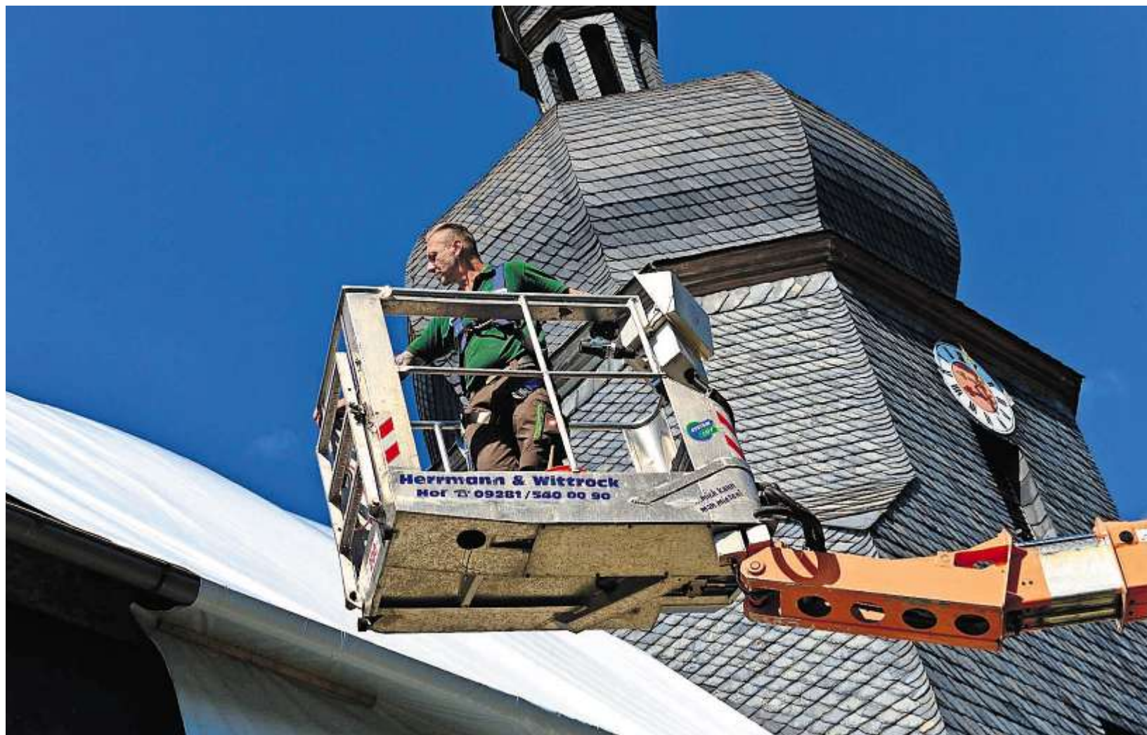
Mit mehr als 1400 Quadratmetern gasdichter Folie wird das Gotteshaus verpackt, hinzu kommen 1,5 Kilometer Klebeband zum Fixieren. Fotos: Carl-Heinz Zitzmann
